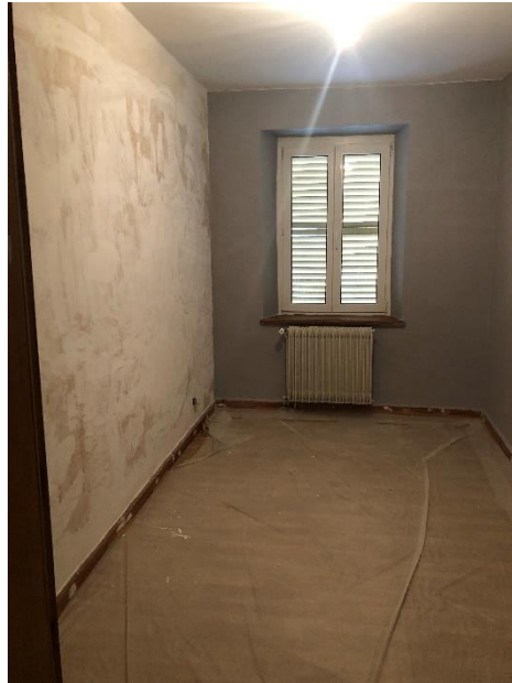
Salle d'expression avec son mur dédié à la craie en cours de travaux
